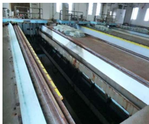
写真 2-2 保台浄水場(フロック形成池・急速ろ過池)
