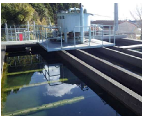
写真 2-3 東町浄水場(高速凝集沈殿池・急速ろ過池)
