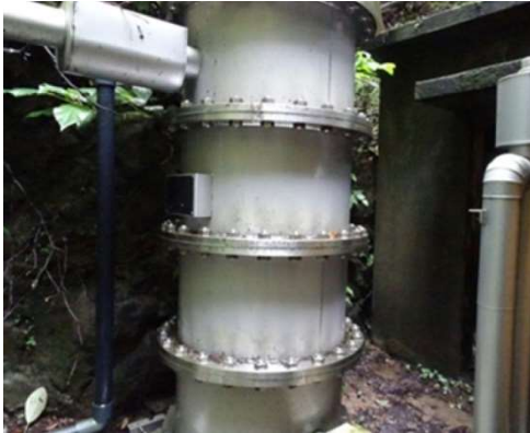
写真 2-5 清澄浄水場(急速ろ過装置・送水ポンプ設備)
