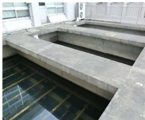
写真 2-1 横渚浄水場(高速凝集沈殿池・急速ろ過池)
