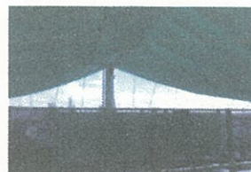
仮設テント使用例
