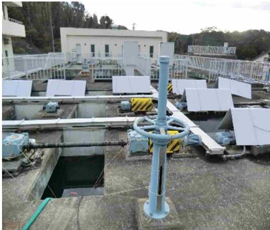
写真 2-2 保台浄水場（フロック形成池・急速ろ過池）
