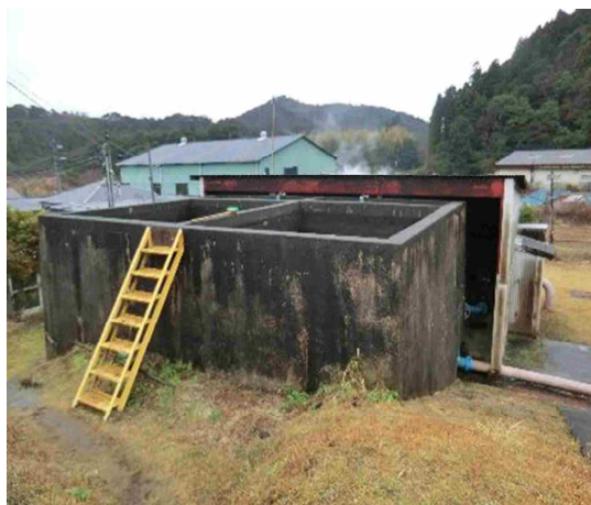
写真 2-4 奥谷浄水場（薬品沈殿池・急速ろ過池）
