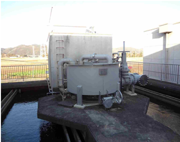
写真 2-1 横渚浄水場（高速凝集沈殿池・急速ろ過池）
