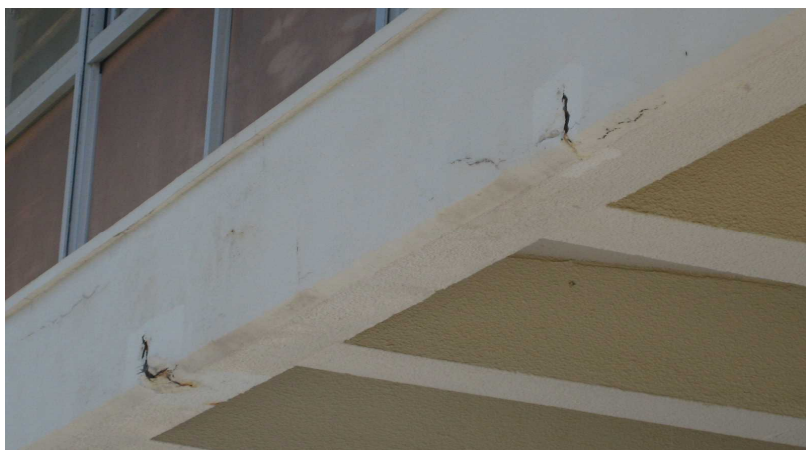
③ 園舎壁面のモルタルの剥離（一部クラックあり）
